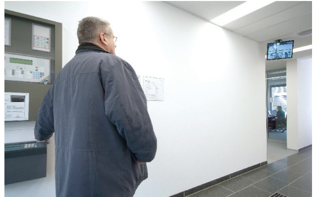
Eingangsbereich, Arbeitszeiterfassung, Blick auf Monitor
