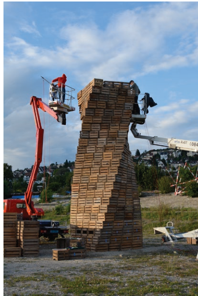
In der Zeitspanne von 16 Stunden bauten wir den Turm mit zwei Selbstfahrhebebühnen.
