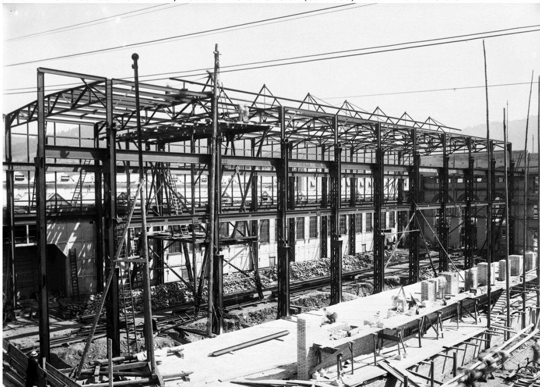
Foto 2: Historisches Archiv ABB, Bau der Trafo Halle 37 (ca. 1950) Brown Boveri & Cie.
