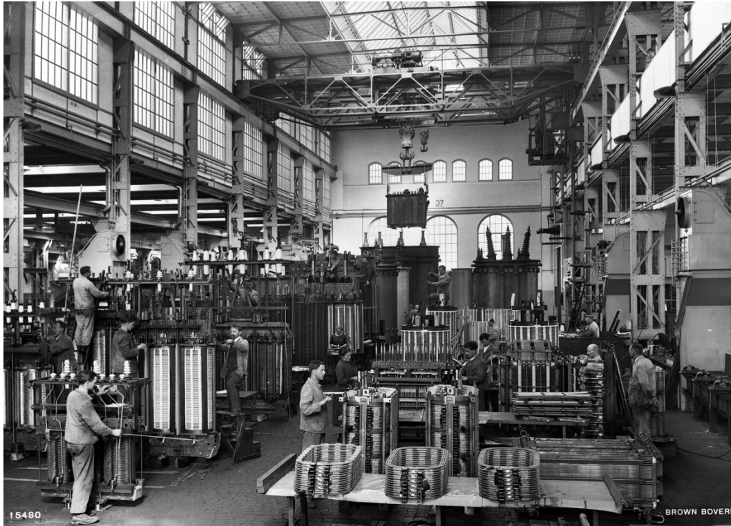
Foto 3: Historisches Archiv ABB , Trafo Halle 37 (50er Jahre), Brown Boveri & Cie.
